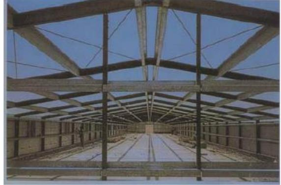
شكل المباني سابقة التجهيز (الهيكل المعدني ثم المواد العازلة للحرارة)
