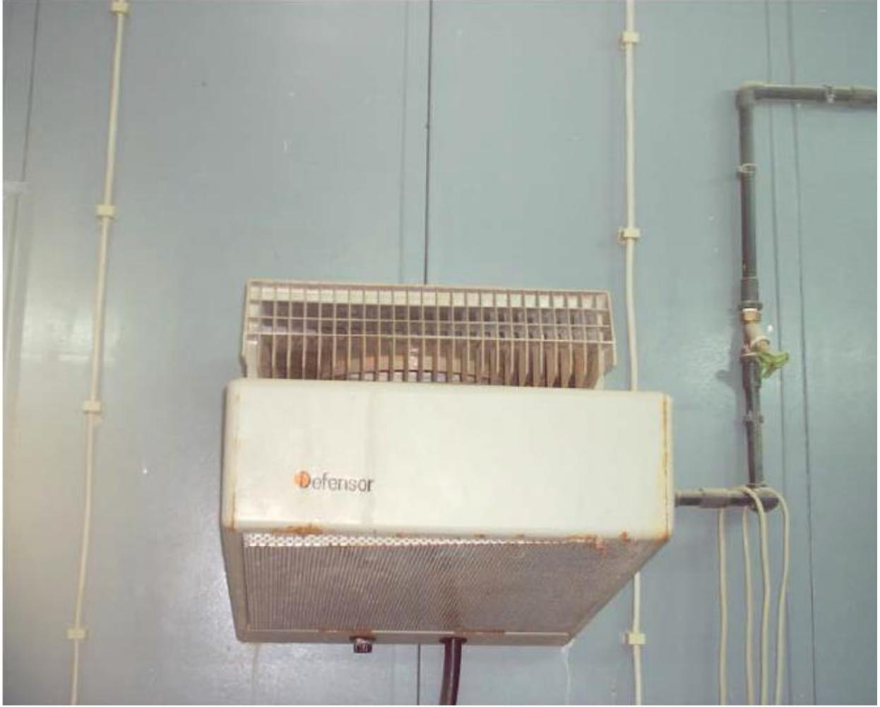
شكل (11) جهاز رفع نسبة الرطوبة
