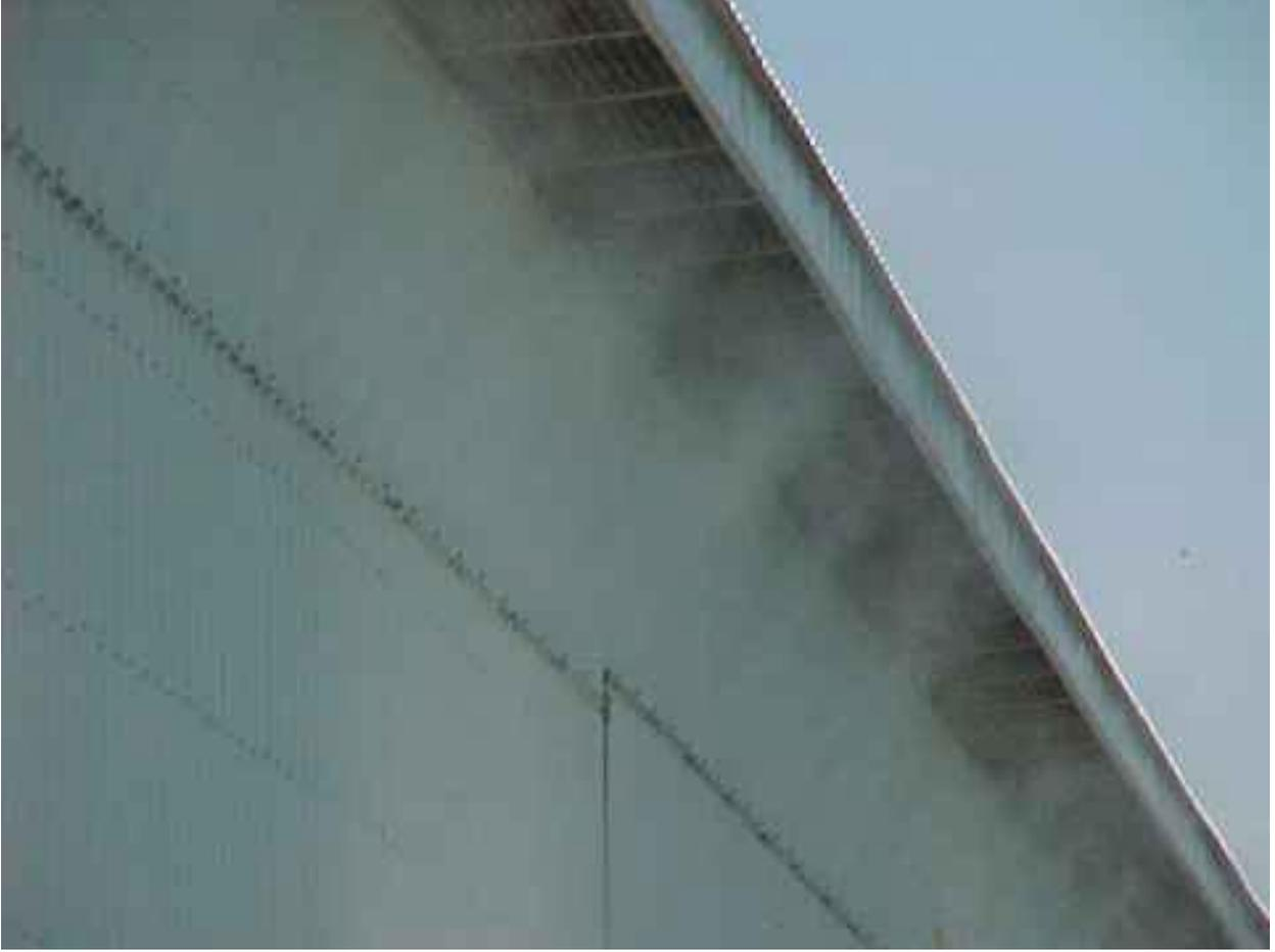
شكل رقم ( 7 ) يوضح تركيب خطوط رذاذ المياه خارج الحظيرة
