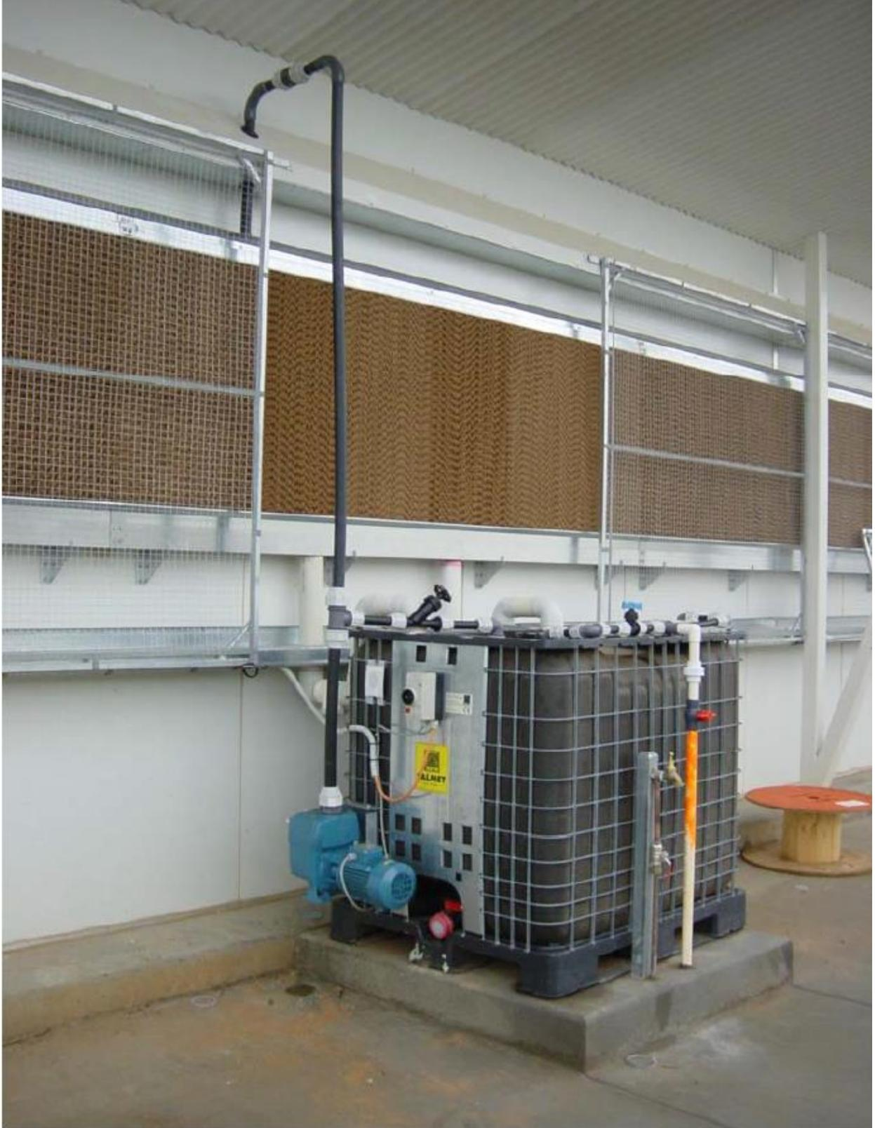
شكل رقم ( 4 ) يوضح دورة المياه في خلايا التبريد
