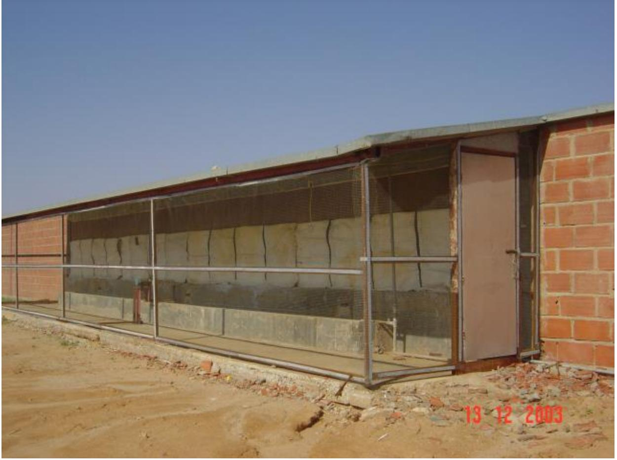
شكل رقم ( 8 ) يوضح تركيب شبكة من السلك لحماية خلايا التبريد من الخارج، ومنع وصول الطيور البرية إليها
