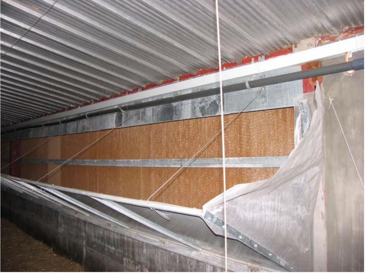
شكل رقم ( 5 ) موجّهات الهواء البارد داخل الحظيرة Air deflectors
