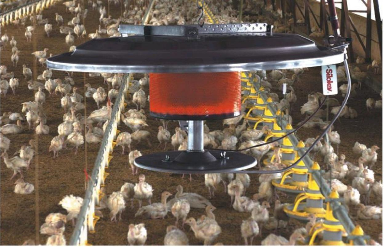
شكل يبين التدفئة بالإشعاع الحراري
